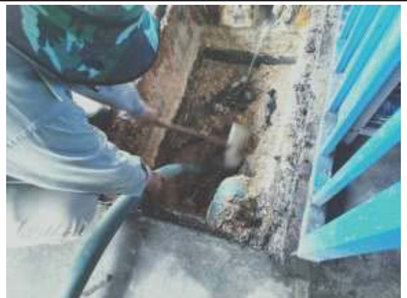
ภาพที่ 18 เจ้าหน้าที่ดูแล ทำความสะอาดถังดักไขมัน
