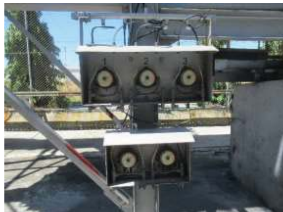
ภาพที่ 2 วาล์วควบคุมความดันก๊าซ
