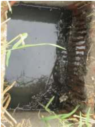
ภาพที่ 15 บ่อพักน้ำทิ้งจากอาคารสำนักงาน
